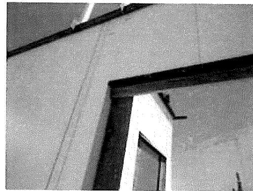
Figura 16 – Escoramento de aberturas de portas para concretagem
